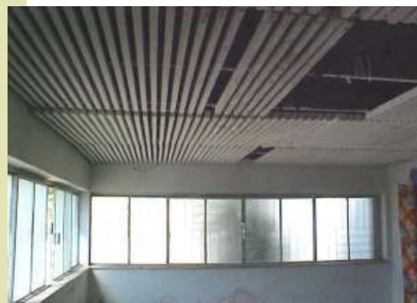
Forro em madeira do hall superior a ser restaurado
