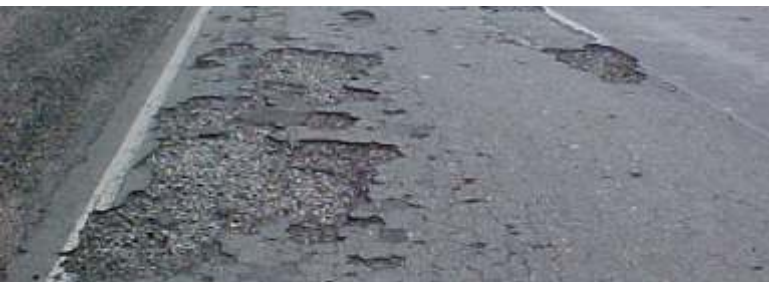
Obra necessita serviços de tapa buracos, roçagem, limpeza e pintura de calha. GO-164, trecho: Araguapaz/ Mozarlândia
